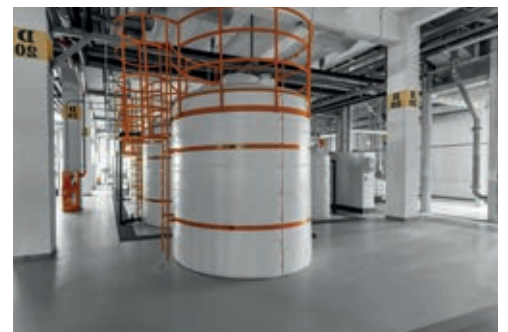
Beton hersteld en vloer gecoat. Tevens hebben we de GRP looproosters van de afwateringskanalen geproduceerd en gemonteerd / Le béton a été réparé et le sol revêtu. Nous avons également produit et installé les caillebotis en GRP pour les canaux de drainage.
