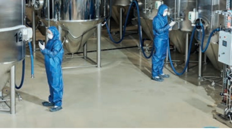
Mineral Composite vloercoating in een chemische fabriek Revêtement de sol de Mineral Composite dans une usine chimique
