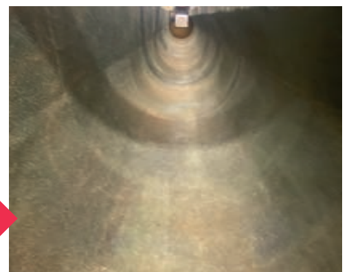
Beton hersteld en vloer gecoat. Tevens hebben we de GRP looproosters van de afwateringskanalen geproduceerd en gemonteerd / Le béton a été réparé et le sol revêtu. Nous avons également produit et installé les caillebotis en GRP pour les canaux de drainage.
